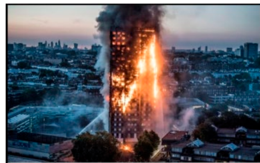
ระบบแจ้งเตือนเหตุไหม้/ฉุกเฉิน/ดับเพลิงอัตโนมัติ
