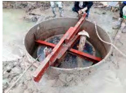
10. ยึดท่อ Shaft ติดกับ Temporary Casing ชั่วคราว
